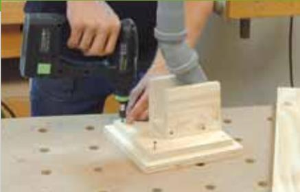
4. Zeichnen Sie auf der großen Bodenplatte zwei Diagonalen ein und positionieren Sie die kleine Bodenplatte mit den Ecken exakt auf den Strichen. Verschrauben Sie die beiden Bodenplatten miteinander. Jetzt können Sie den Turm darauf stellen und die Passgenauigkeit des Futterloches kontrollieren. Arbeiten Sie wenn nötig mit einer Raspel oder der Stichsäge am Loch nach.
