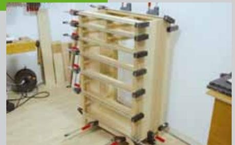
des Frontrahmens mit einzuleimen und verspannen Sie alles mit Zwingen. Die gezeigten Korpuszwingen drücken auf der gesamten Spannbacke und können deshalb ohne Zulagen eingesetzt werden. Achten Sie darauf, dass alle Fugen geschlossen sind und kontrollieren Sie, wenn alle Zwingen angesetzt sind, durch Messen des Diagonalmaßes, ob der Korpus rechteckig ist.
