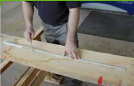
1. Zeichnen Sie sich auf die rohen Bretter ungefähr die Länge der einzelnen Teile an, Längenzugabe zum Fertigmaß ca. 50 mm. Beim Anzeichnen der Längen auf der rohen Bohle wird auch ein großer Teil der Holzauswahl getroffen. Achten Sie also darauf, dass Äste und Fehlstellen nach Möglichkeit wegfallen. Um diese zu erkennen sollten die Bohlen möglichst sauber sein.
