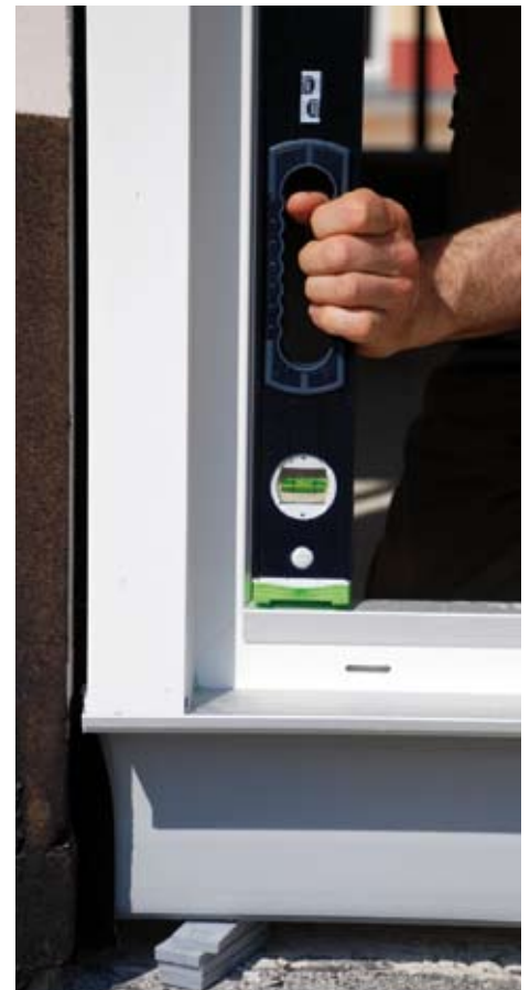
Integrierte Griffe erleichtern das Halten der Wasserwaage erheblich.
