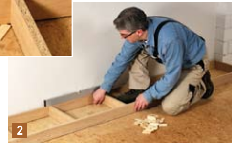
Mit unterschiedlich dicken Holzstreifen wird das Sockelgerüst sorgfältig unterfüttert, bis es sich perfekt „in der Waage“ befindet.
