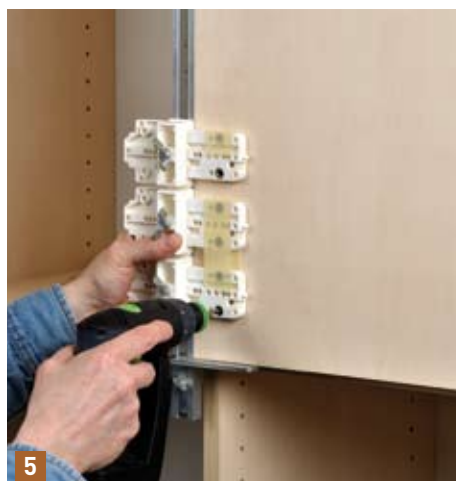
Bei acht Türen lohnt es sich zur Griffmontage eine Bohrlehre einzusetzen. Verschließen Sie aber die nicht benötigten Bohrbuchsen unbedingt mit Klebeband, denn bei so vielen Bohrungen verliert man schnell den Überblick.
