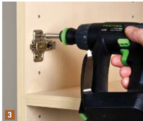
Bevor Sie die Türen einhängen können, werden zuerst die so genannten Montageplatten in die passenden Löcher der Seitenwand festgeschraubt.
