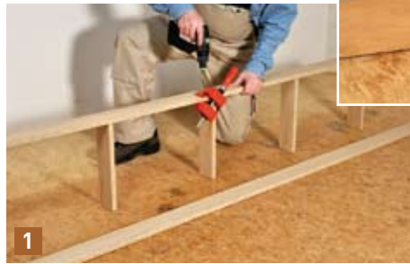
Der Schranksockel ist ein Gerüst aus schmalen Plattenstreifen in der gewünschten Sockelhöhe, die stumpf zusammenschraubt werden.
