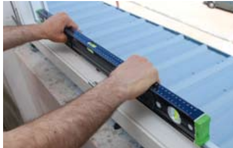
Die LEV 800 von Festool bei der Fenstermontage.
